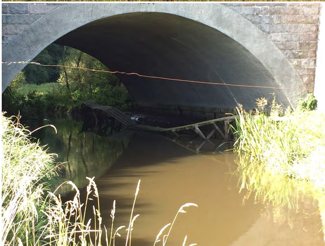
Figur 21. Passage over og under jernbanen, hvor den krydser Kolding Å. Foto: Kolding Kommune.
