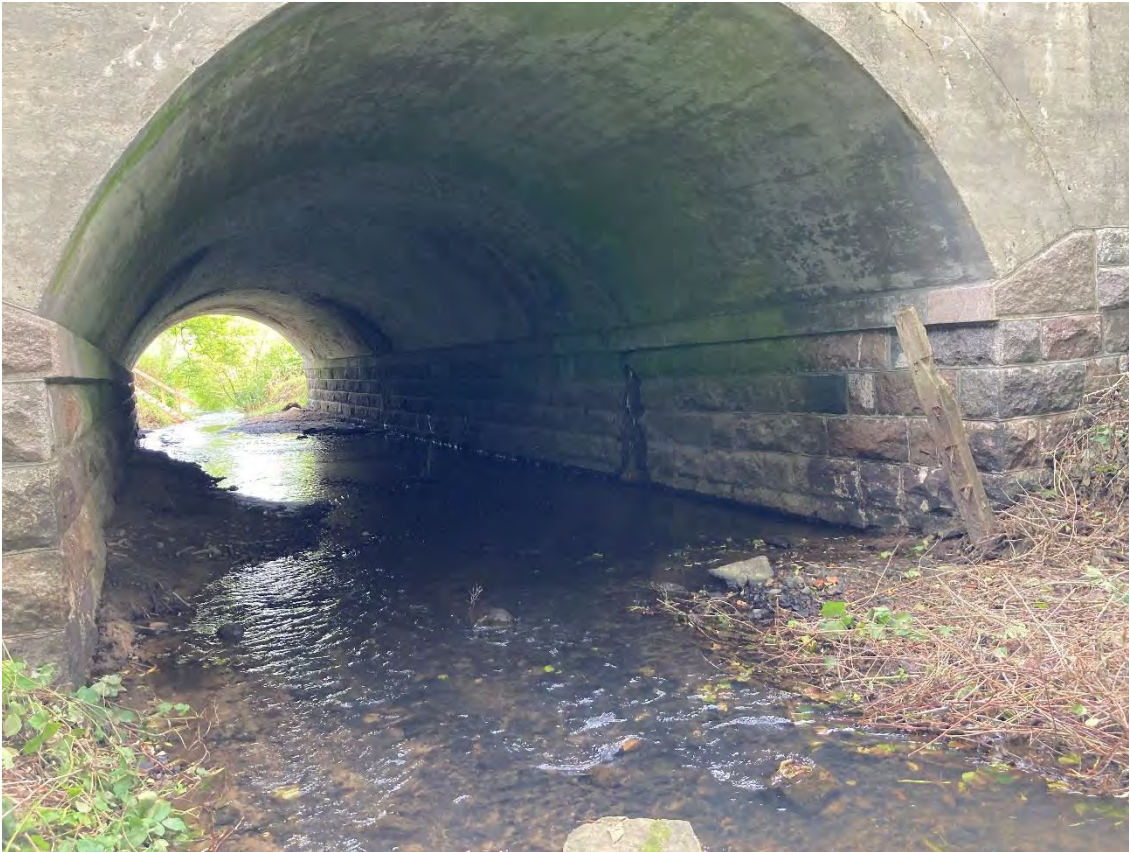
Figur 24. Passagen under jernbanen, hvor den krydser Seest Mølleå, har ingen faste banketter. Foto: Kolding Kommune.
