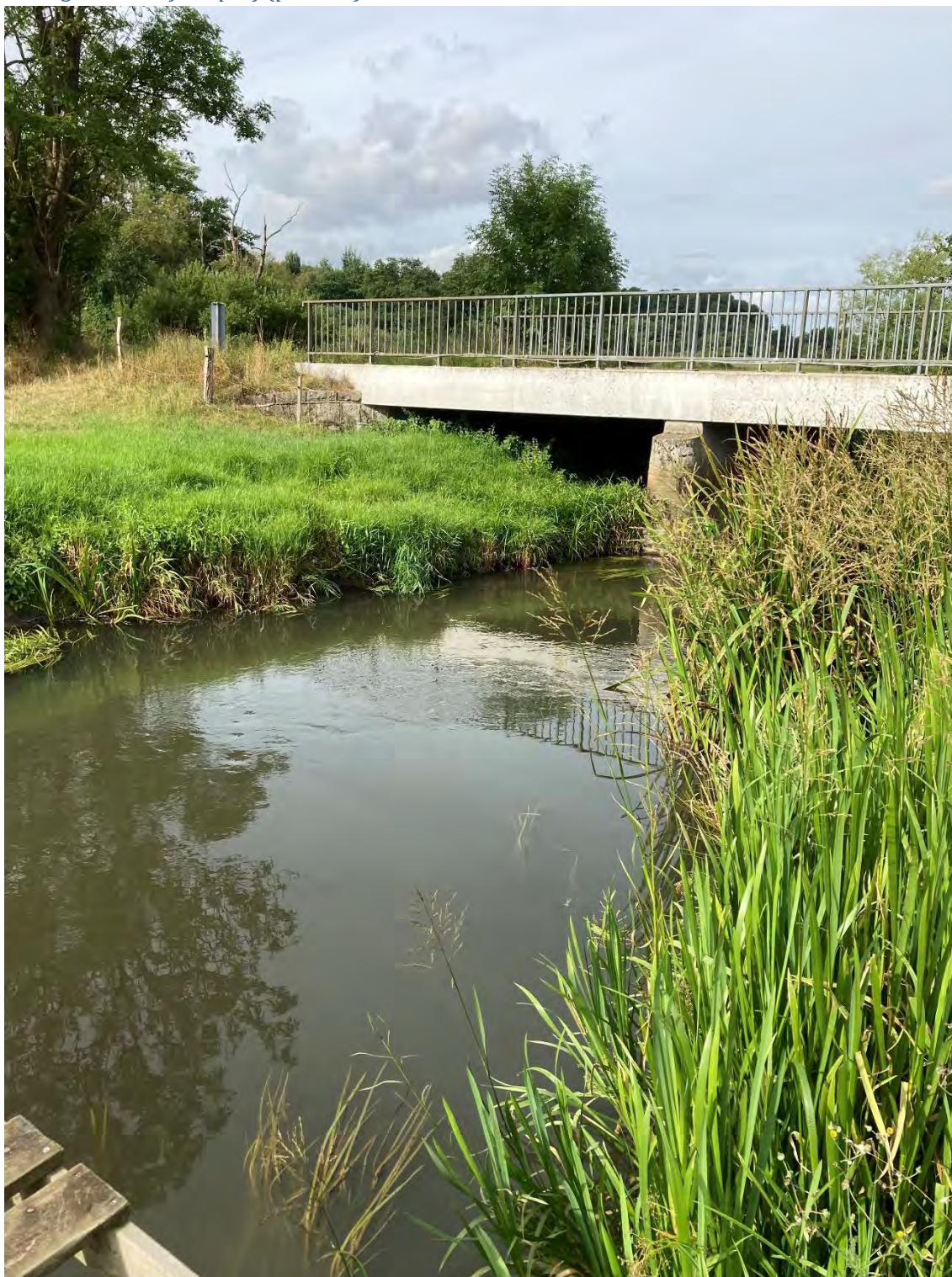
Figur 23. Ejstrupvej krydser Kolding å på en lav bro. Foto: Kolding Kommune.
